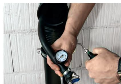
Aufpumpen der Prüfblase mit Blasebalg; Prüfblase der Reinigungsöffnung einer Abwasserleitung
