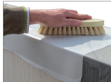
Beklebte Schare bei einer Doppelstehfalzdeckung
